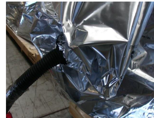
Absaugen der Luft an der Folie
