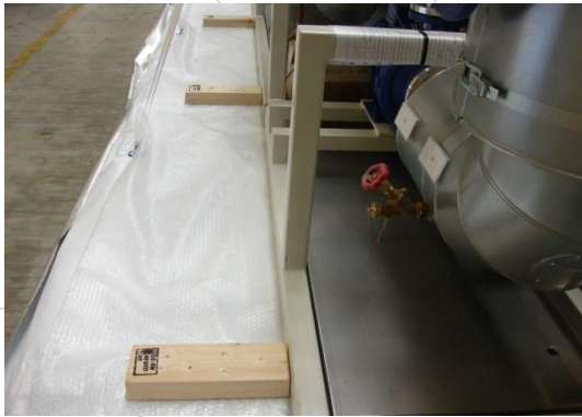
Sicherung durch Holz / Holzkeile
